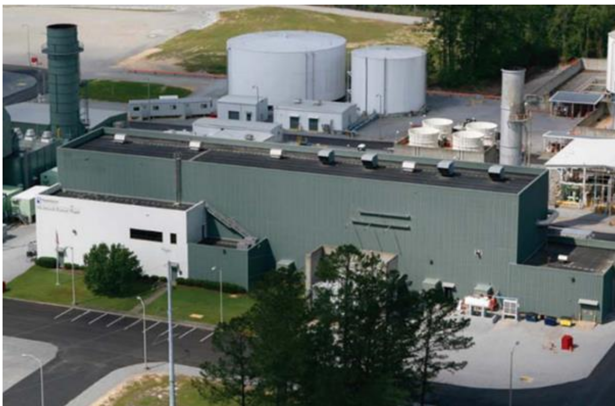
Figura 14 - A central CAES de McIntosh, Alabama, EUA, com 110 MW e 2860MWh.
