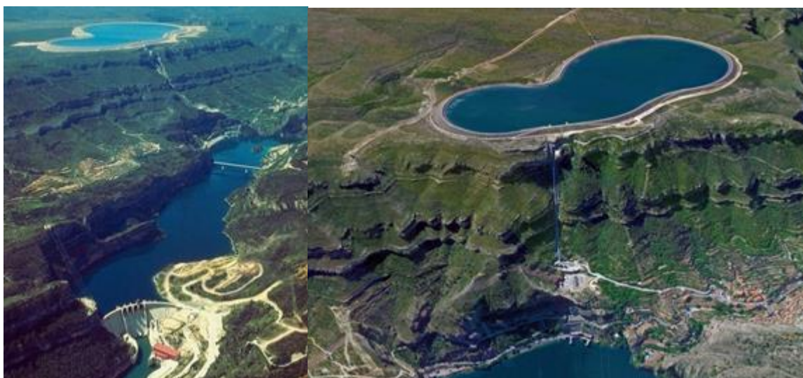
Figura 12 - Central de bombagem hídrica de La Muela com 1,8 GW de bombagem e capacidade de 5 GWh de armazenamento, semelhante à futura central do Gouvães/Tâmega.
